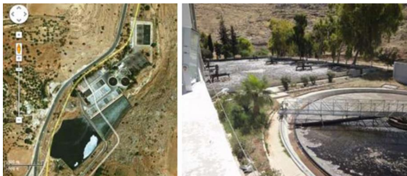
Figure 14 : Installation d'épuration d'Al Salt
