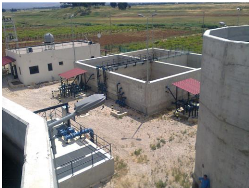
Ablah, Liban – Station d'épuration des eaux usées
