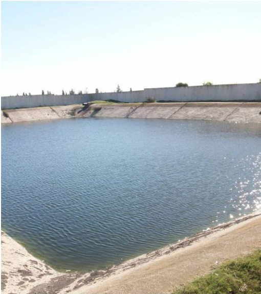
Nabeul, Tunisie – Bassin de stockage des eaux usées traitées
