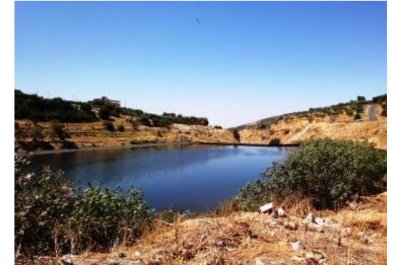
Salt, Jordanie – Bassin de stockage des eaux usées traitées
